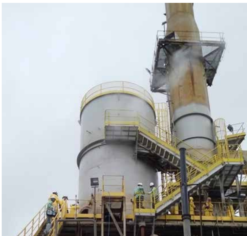
Figura 16 – Fotos destacando a IPAT Antes (acima) e depois (abaixo), com a nova cabeça, novo espelho, e nova BV com escada e plataforma de acesso.
