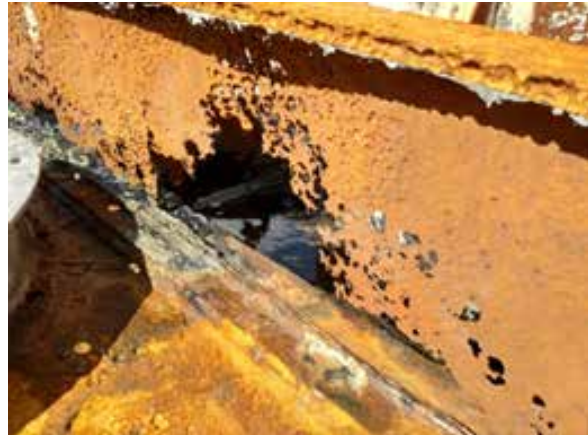
Figura 4: Estrutura mecânica do espelho dramaticamente comprometida
