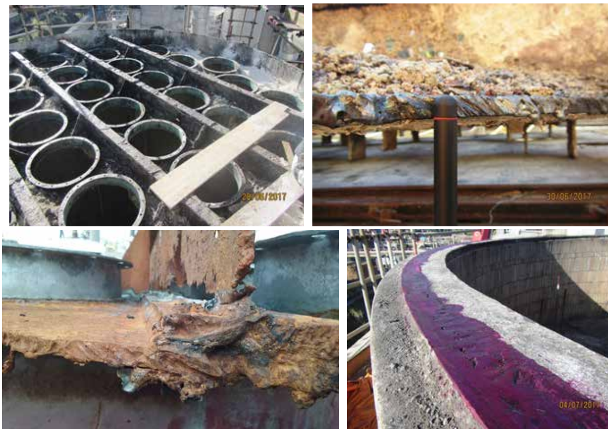
Figura 14 – Remoção do antigo espelho.
