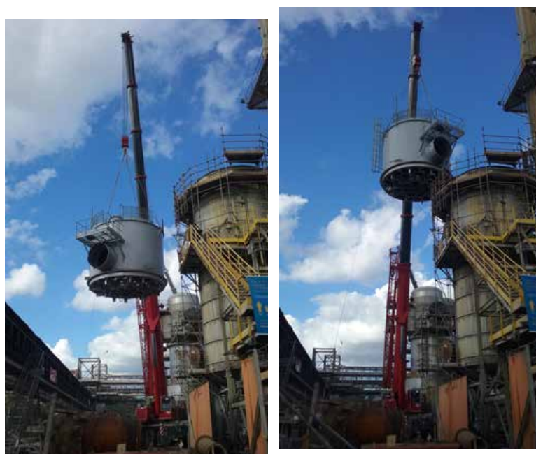
Figura 15 – Instalação da nova cabeça da Torre
