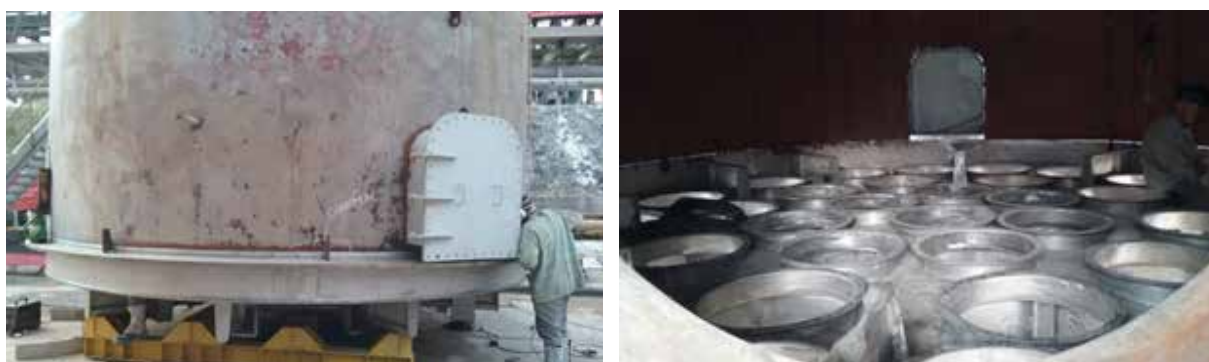
Figura 13 – Cabeça alinhada com novo espelho e nova BV soldada no costado
