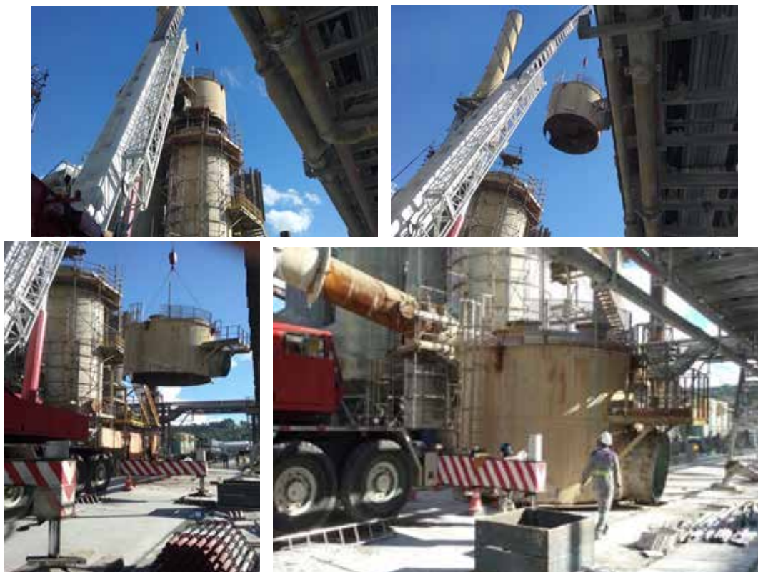
Figura 12 – Movimentação da nova cabeça da IPAT
