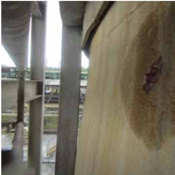
Figura 9 – Deformações identificadas no Costado
