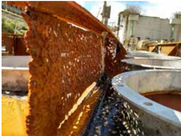
Figura 4: Estrutura mecânica do espelho dramaticamente comprometida
