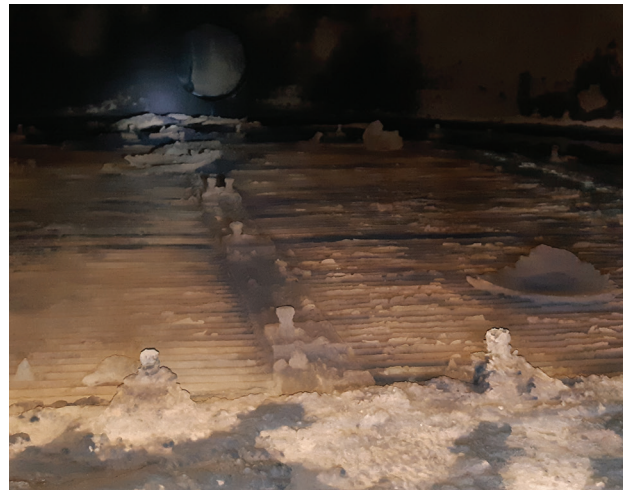
Figura 1 - Separador de arraste incrustado
