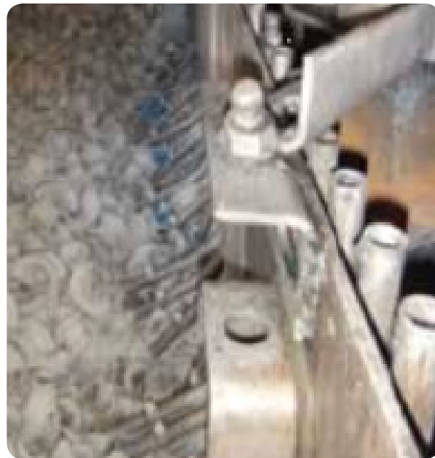
Figura 3 | Pinos do downcomer e fixação das calhas.
