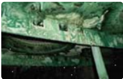
Figura 6 | Espelho de suporte cortado para caber os parafusos.
